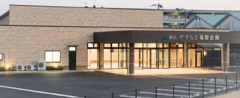
やすらぎ福智会館 外観写真
